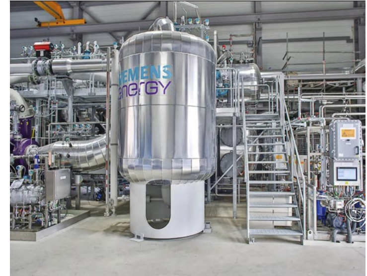
Großwärmepumpe ebswien Kläranlage Simmering
