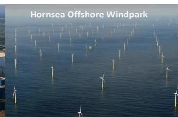
165 Windkraftanlagen á 8 MW = 1,3 GW
